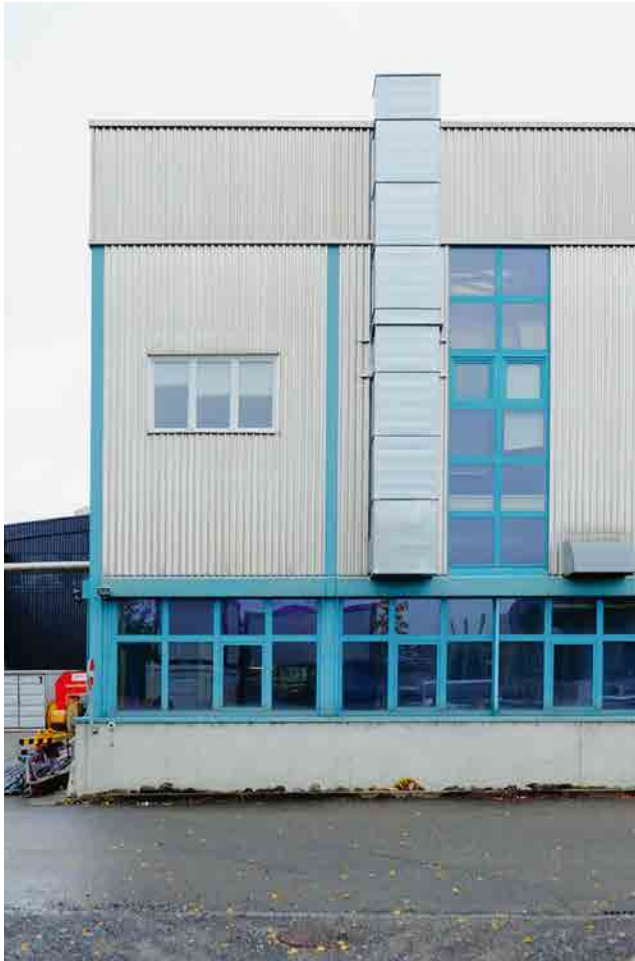
Die Halle vor den Umbaumaßnahmen.
