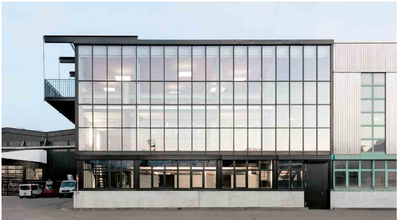
Der Umbau wertete die Fassade in der betroffenen Gebäudeecke optisch auf. Transparent, mit einem Balkon versehen und als Pfosten-Riegel-Konstruktion ausgeführt, korrespondiert sie mit dem Rhythmus des Bestands .
