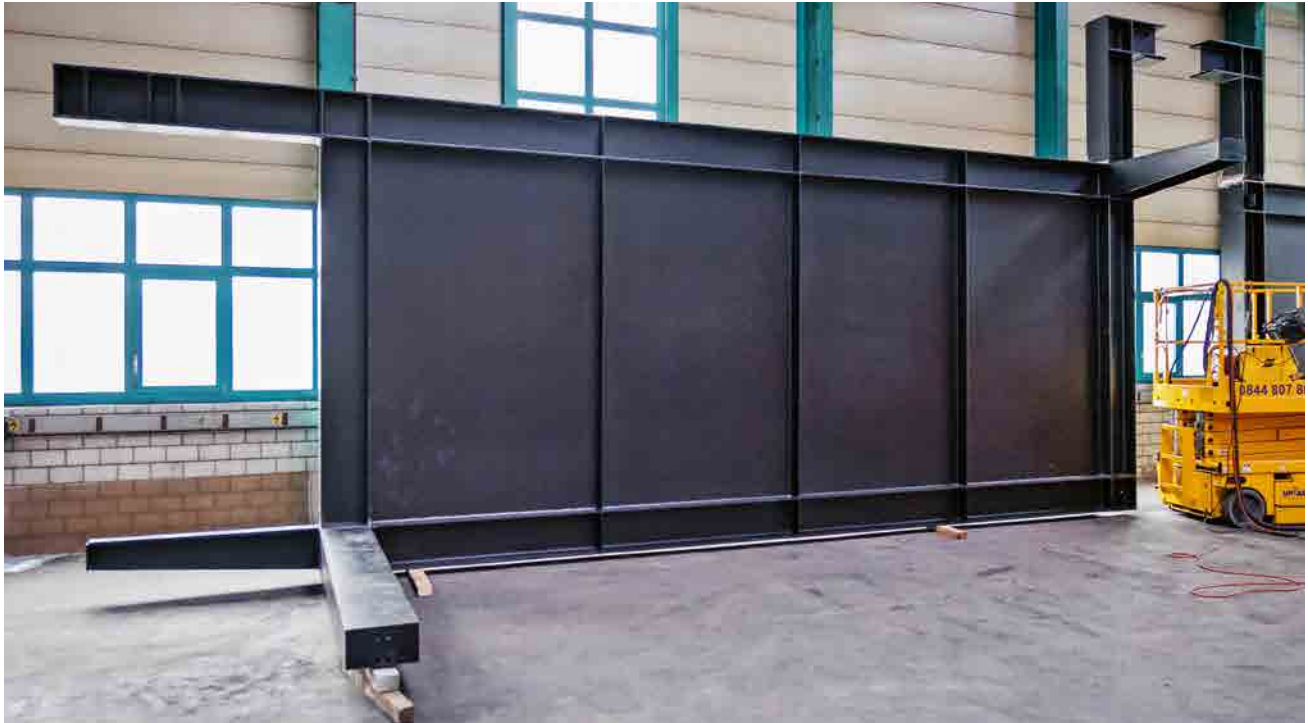
Eins der beiden Stahl-Seitenteile vor dem Einbau. Deutlich sind hier die verschiedenen Profile und Stahlbleche zu erkennen, aus denen sich das Bauelement zusammensetzt.
