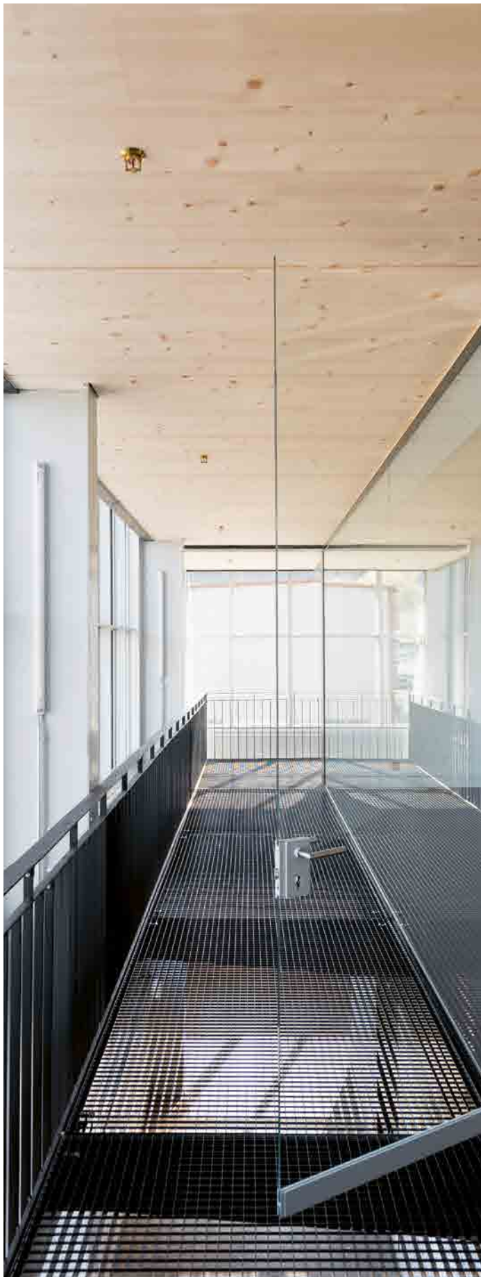
Im 1. OG führt fassadenseitig ein Gang entlang des Schulungsraums. Er lagert auf auskragenden Trägern, als Lauffläche dienen Gitterroste.
