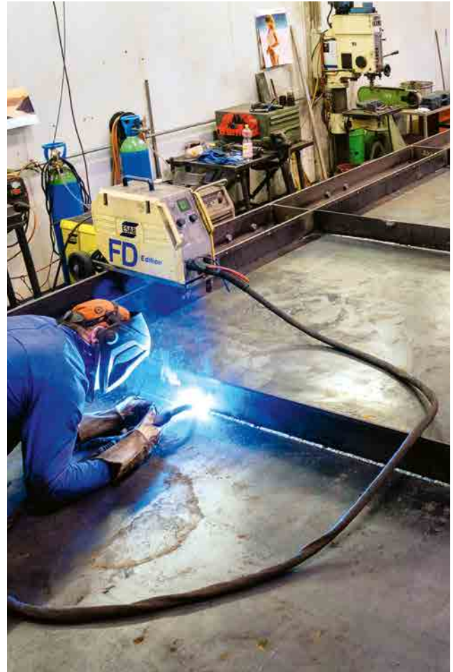
Schweissarbeiten bei der Vormontage der Stahlwangen.
