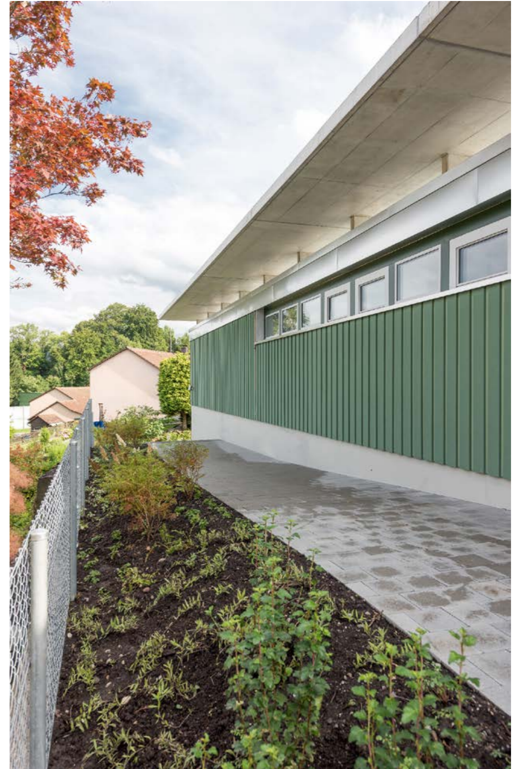
Eingang mit neuem Vordach
