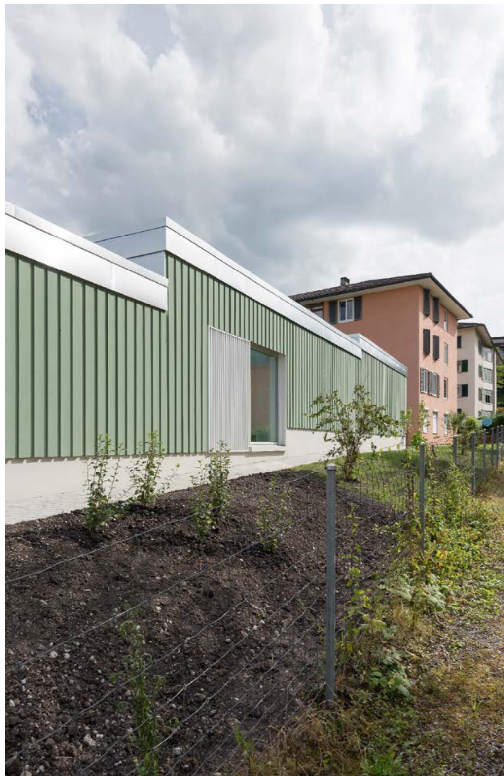
Aussenfassade mit Bretterschalung
